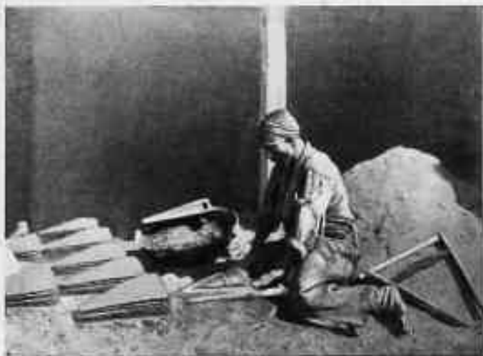
Рис. 2. Формовка. Изготовление из песка форм для отливки лемехов. Фото С. Дудина. ГМЭ (Ленинград).
