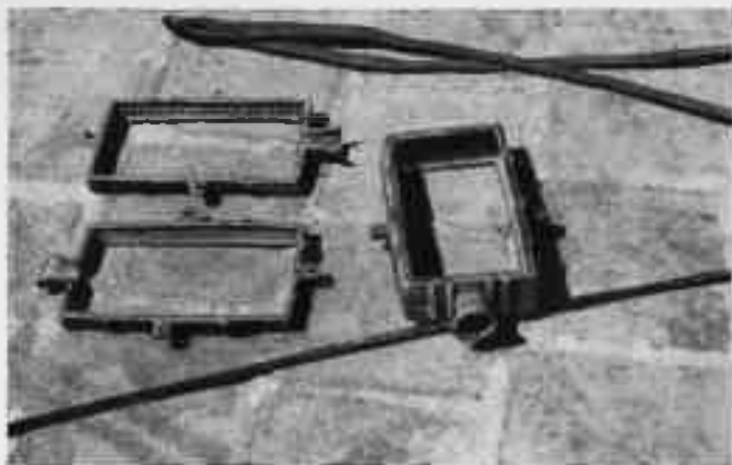
Рис. 5. Инструменты литейщиков бронзы. Бухара. Фото Е. Н. Юдицкого. 1960 г.
