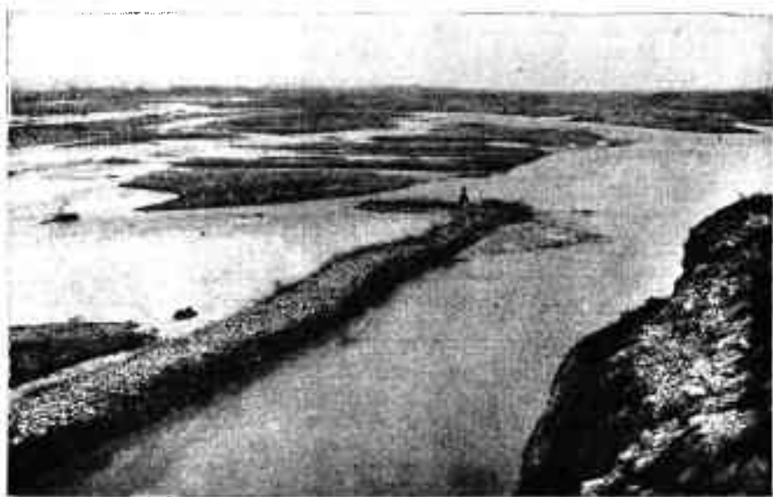
Шох-шабба, тош ва чимлардан ишланган каналга сув боғлаб олувчи тугон
