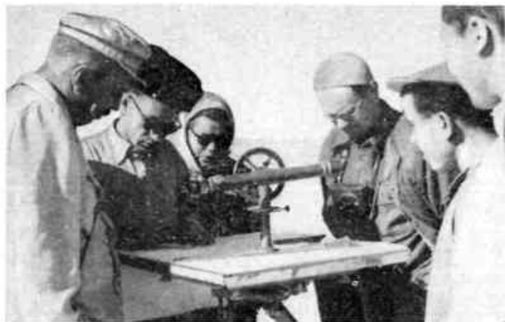
Рис. 1. Полевые археолого-топографические работы (мензуральная съемка). Слева направо: С. П. Толстов, Н. И. Игонин, А. А. Юдина, Б. В. Андрианов и др.
