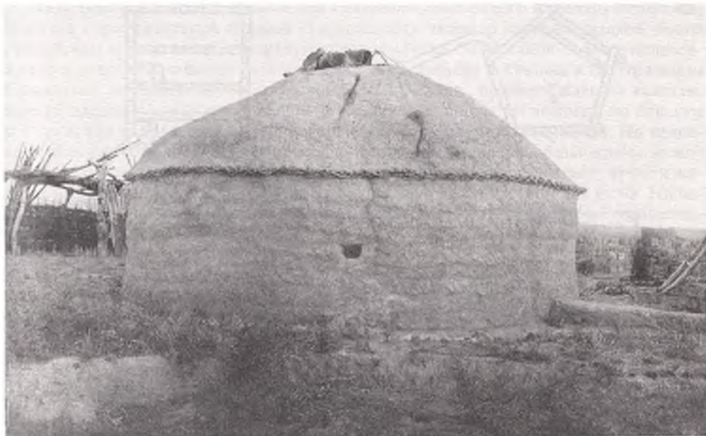
Рис. 2. Шошала из саманного кирпича. Баянаульский р-н, Павлодарский уезд, Семипалатинская губ. 1927 г. (по: Архив Ф.А. Фиельструпа)
