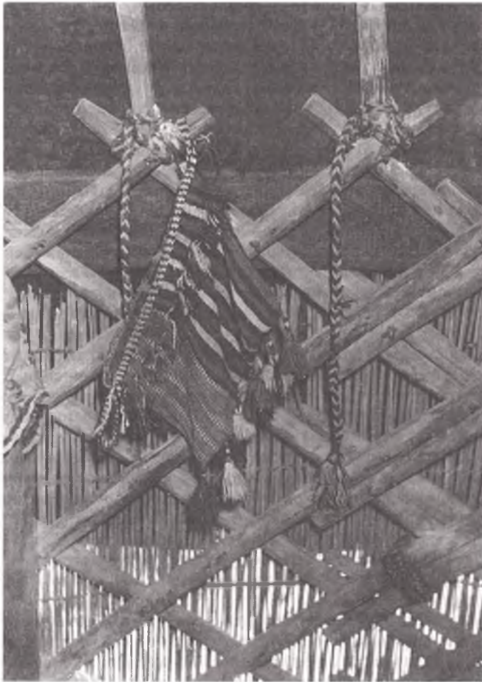
Рис. 1. Скрепление купольных жердей с решеткой юрты. Кишлак Хаттак Шерабадского р-на Сурхандарьинской обл. Узбекистана. 1961 г.
