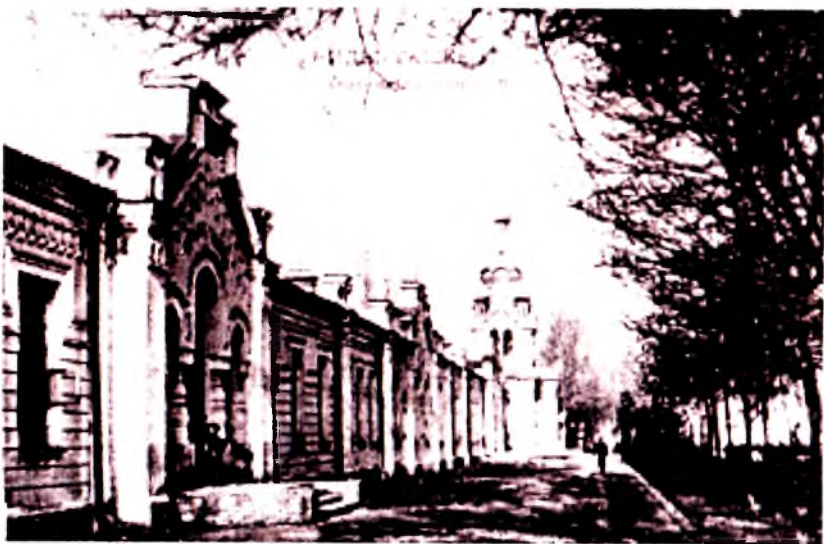
8-расм. Ўқитувчилар семинарияси. 1881 йилда қурилган. Ҳозирги Матбуотчилар кўчасида бинонинг бир қисми сақланиб қолган.
