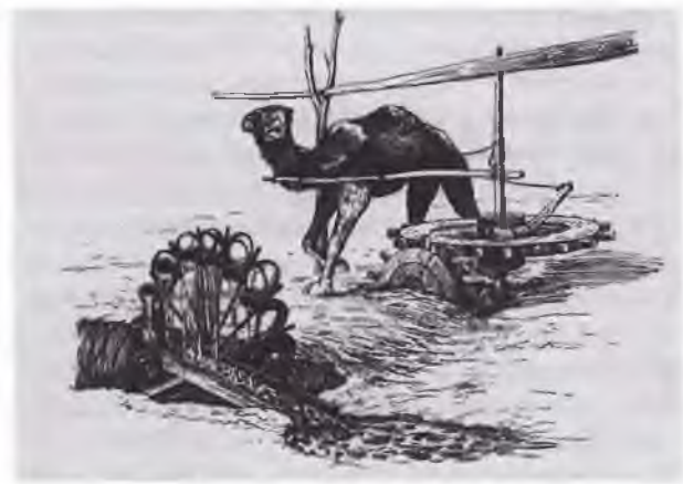
Старинное водоподъемное сооружение чигирь. Хорезм. XIX в.
