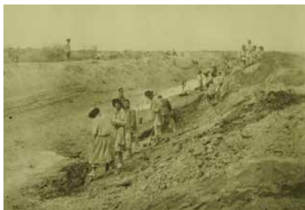
Рис. 5. Строительство канала. Каракалпакская АССР, Муйнакский район. 1946. Фото Т.А. Жданко. НА ИЭА РАН
