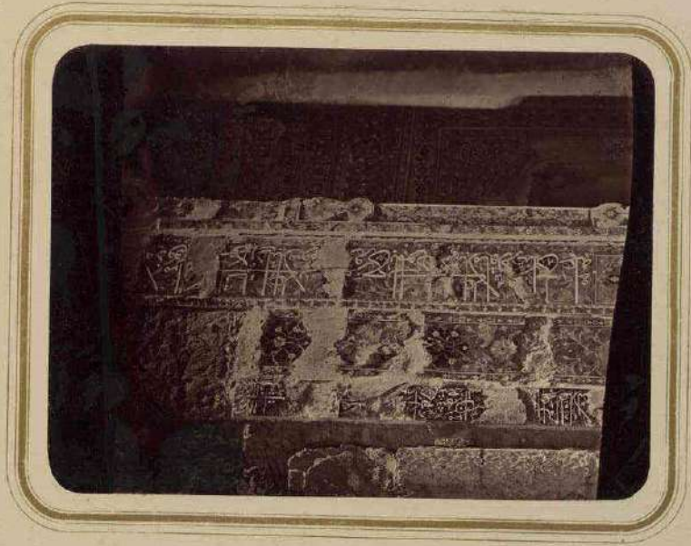
ЧАСТЬ НАЛІВКА СЪ ПРАВОЙ СТОРОНЫ ФАСАДА.
