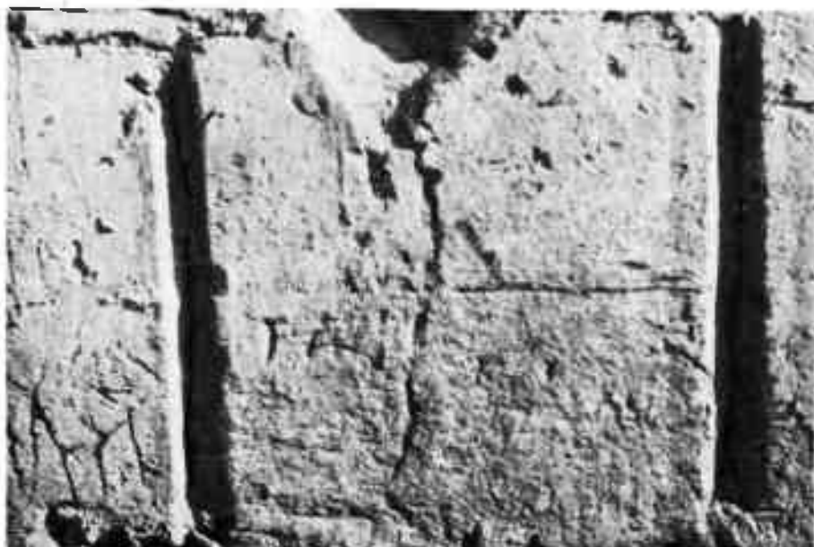
Табл. 9. Кафыркала. Пахсовая стена, прорезанная швами
