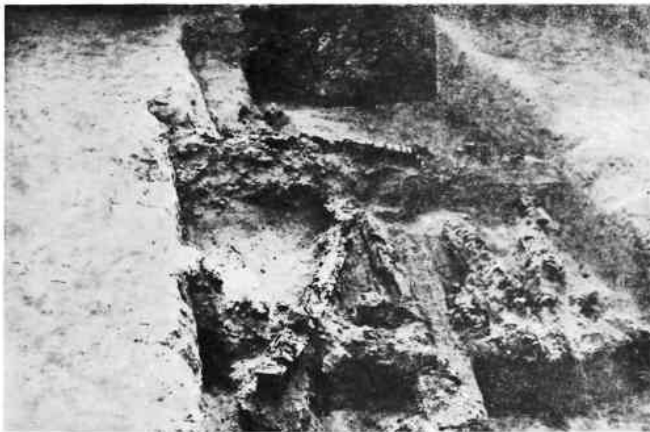
Табл. 4. Нафыркала. Цитадель. Помещение 14. Обгоревшие детали перекрытия
