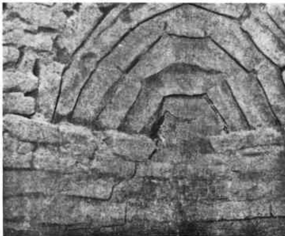
Табл. 12. Кафыркала. Цитадель. Тромп в помещении I
