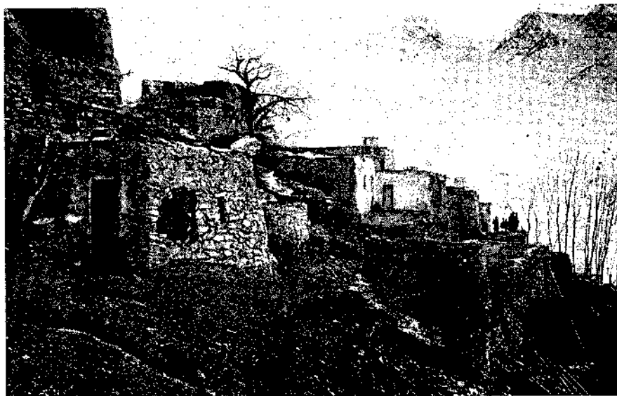
Рис. 6. Жилые и хозяйственные постройки, сооруженные из сланцевого камня в кшлаке Кули-Дахана. Ягноб, 1966 г.
