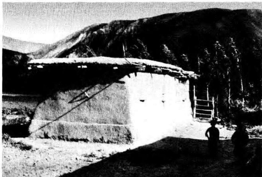
Современный дом, оштукатуренный и побеленный белой глиной. Сел. Кошой. 1957 г. (Фото Б.Х. Кармышевой)
