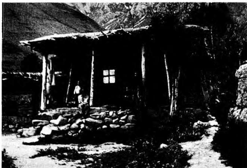
Мехман-хана и мастерская мастера-седельщика. Нижняя часть стен дома выложена из камня. Сел. Кошой. 1957 г. (Фото Б.Х. Кармышевой)
