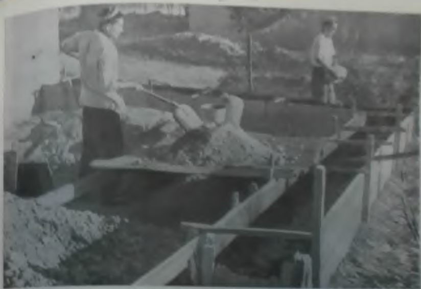
Укладка фундамента дома (х. Навазо; фото Н. С. Карманова)
